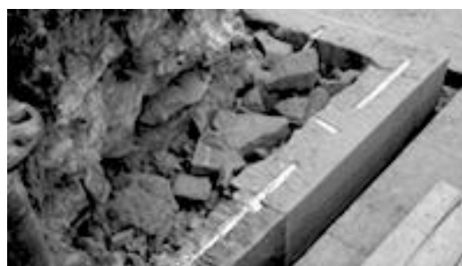
Recontitution de l'angle du tambour et scellement au plomb des barres d'acier joignant les pierres
