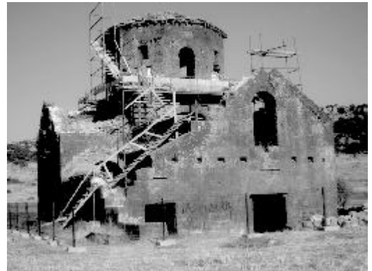
Ci-contre, échafaudage et clôture
