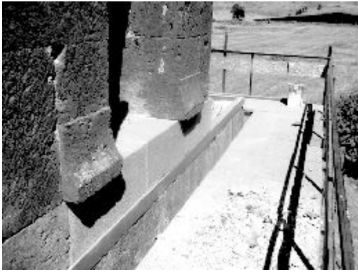
A la base extérieure du tambour, rétablir les pierres manquantes et le chaînage en bois
