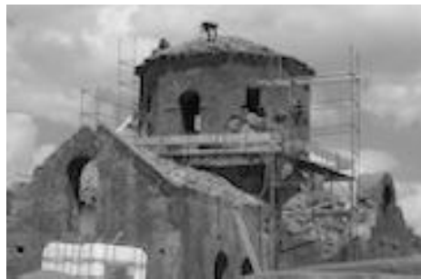
Nettoyage de la toiture
