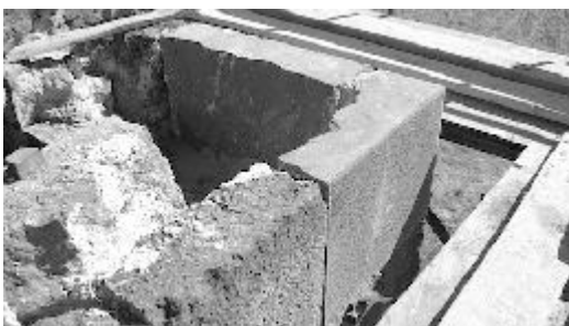
Recontitution de l'angle du tambour et scellement au plomb des barres d'acier joignant les pierres
